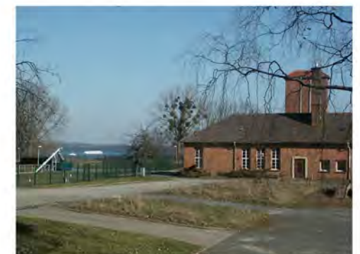
VORHANDENE BEBAUUNG AUF DEM STANDORT
