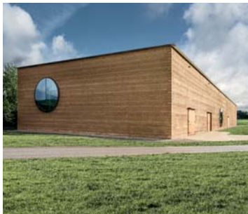
LEHM: RICOLA KRÄUTERZENTRUM
