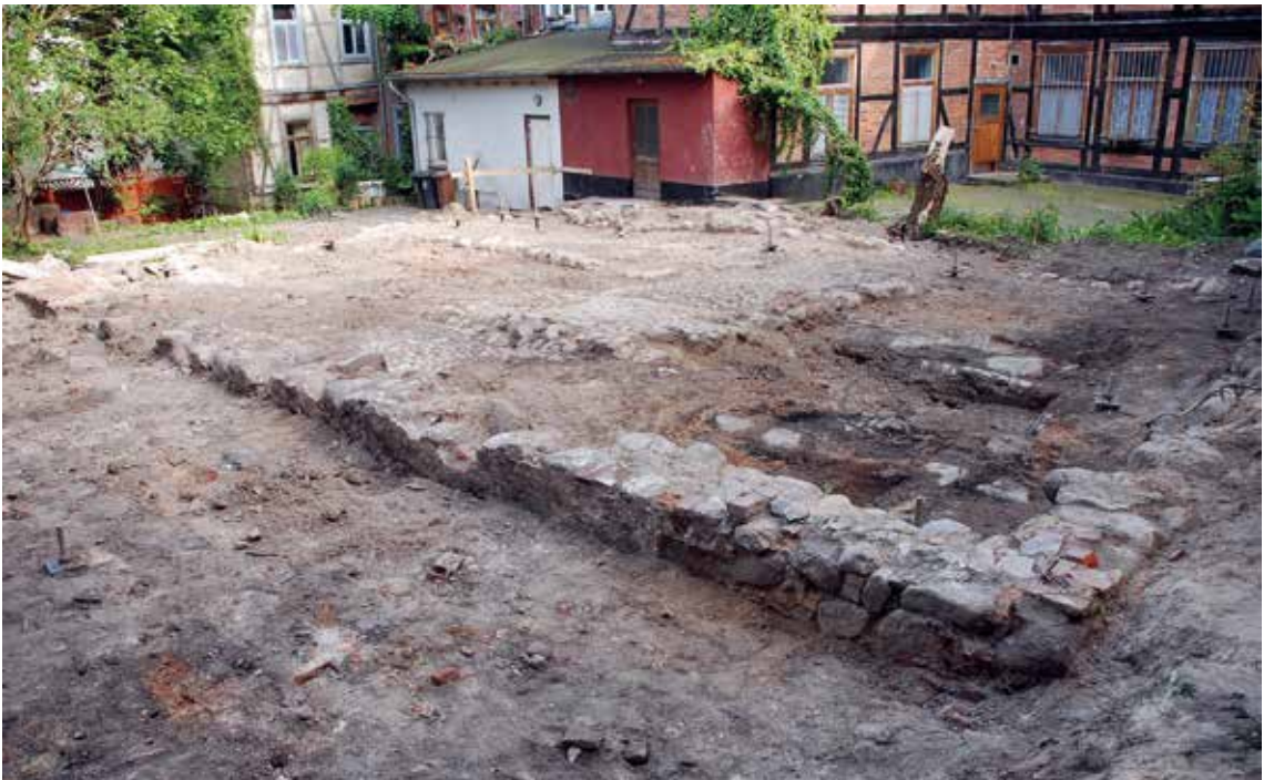
8 Schwerin, Synagoge, historische Synagogenfundamente mit zusätzlicher Bohrpfahlgründung, 2008. Foto: Brenncke Architekten.
