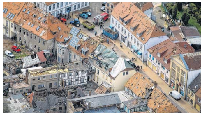
2015 war ein Tornado durch Bützow gezogen und hatte innerhalb von zehn Minuten die Altstadt verwüstet. FOTO: JENS BÜTTNER
